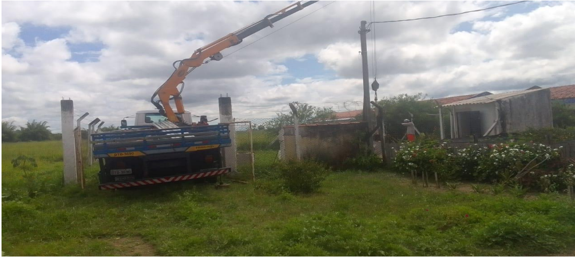
SUBSTITUIÇÃO BOMBA DE 30 HP POR UMA DE 32,5 HP
