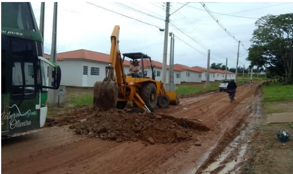
FECHAMENTO DAS VALAS APÓS EXECUÇÃO DAS LIGAÇÕES
