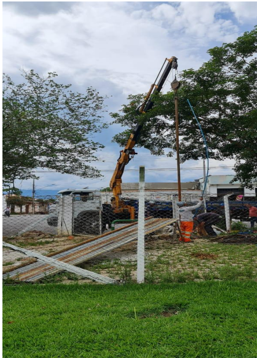
RETORNO BOMBA 35 HP APÓS MANUTENÇÃO
