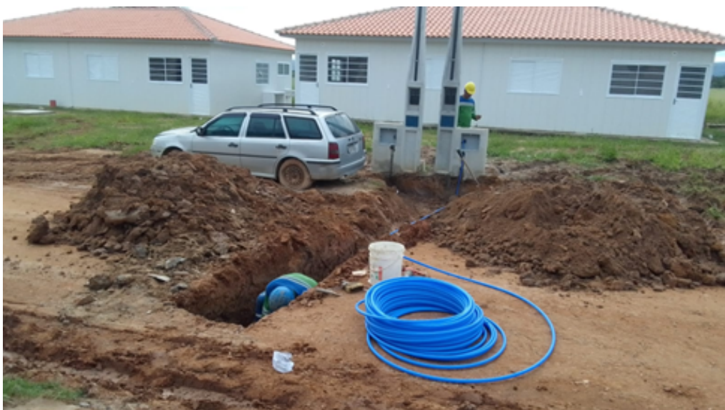
REALIZAÇÃO DAS LIGAÇÕES DE ÁGUA
