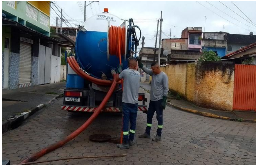
SERVIÇO DE DESOBSTRUÇÃO EM ANDAMENTO
