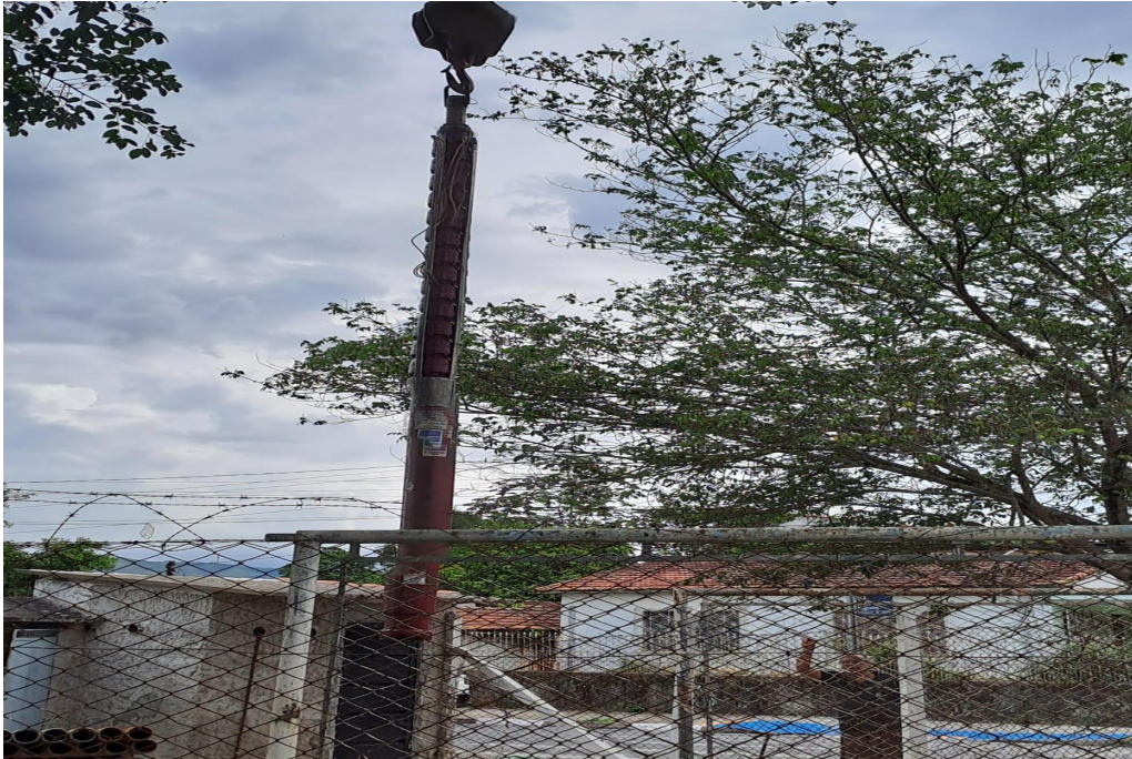
SUBSTITUIÇÃO DA BOMBA POÇO ELIZABETH
