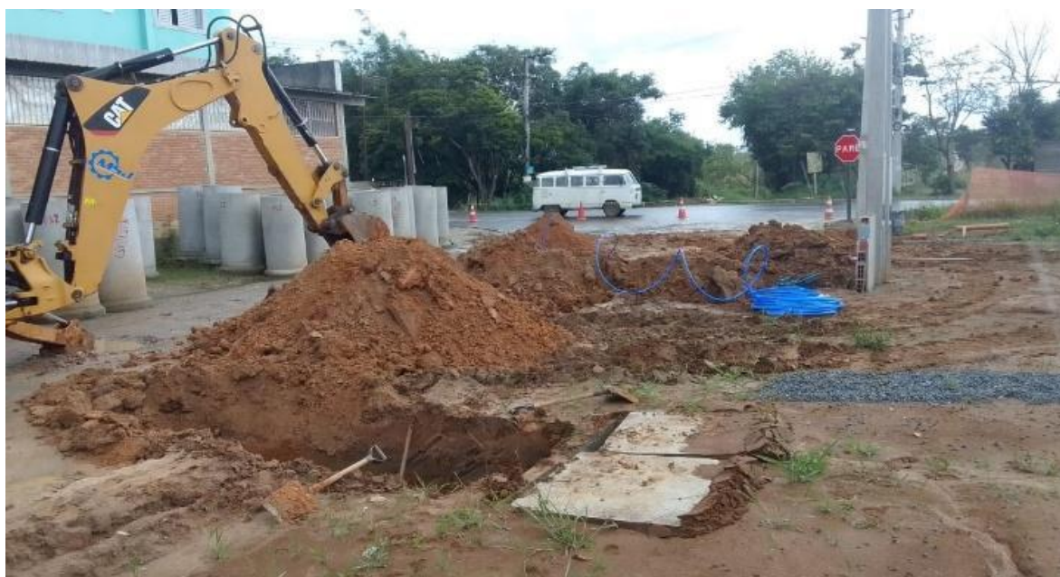
ABERTURA DAS VALAS PARA IMPLANTAÇÃO DAS LIGAÇÕES
