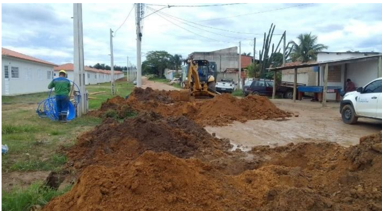
ABERTURA DE VALAS E REALIZAÇÃO DAS LIGAÇÕES
