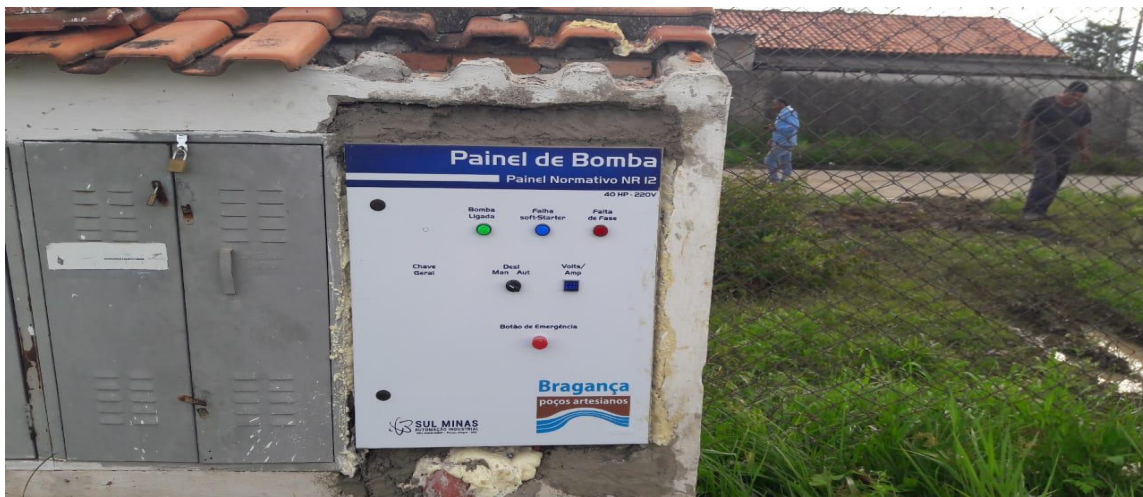
INSTALAÇÃO PARCIAL DE PAINEL ELÉTRICO
