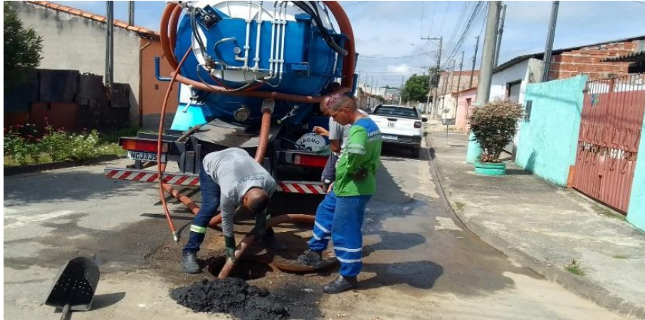
MATERIAL RETIRADO DO POÇO DE VISITA (PV)
