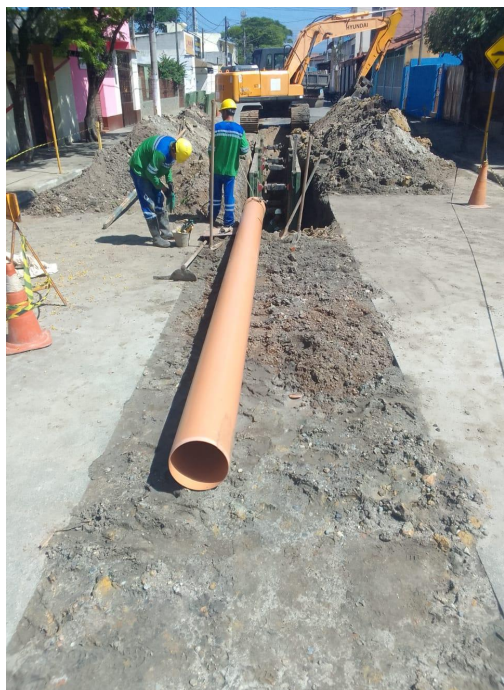
SUBSTITUIÇÃO DO COLETOR TRONCO RUA ADRIANO G. DE CASTRO
