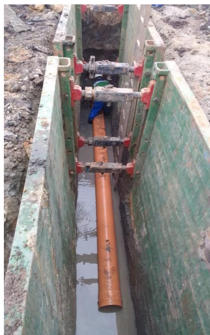
SUBSTITUIÇÃO DO COLETOR TRONCO RUA ADRIANO G. DE CASTRO
