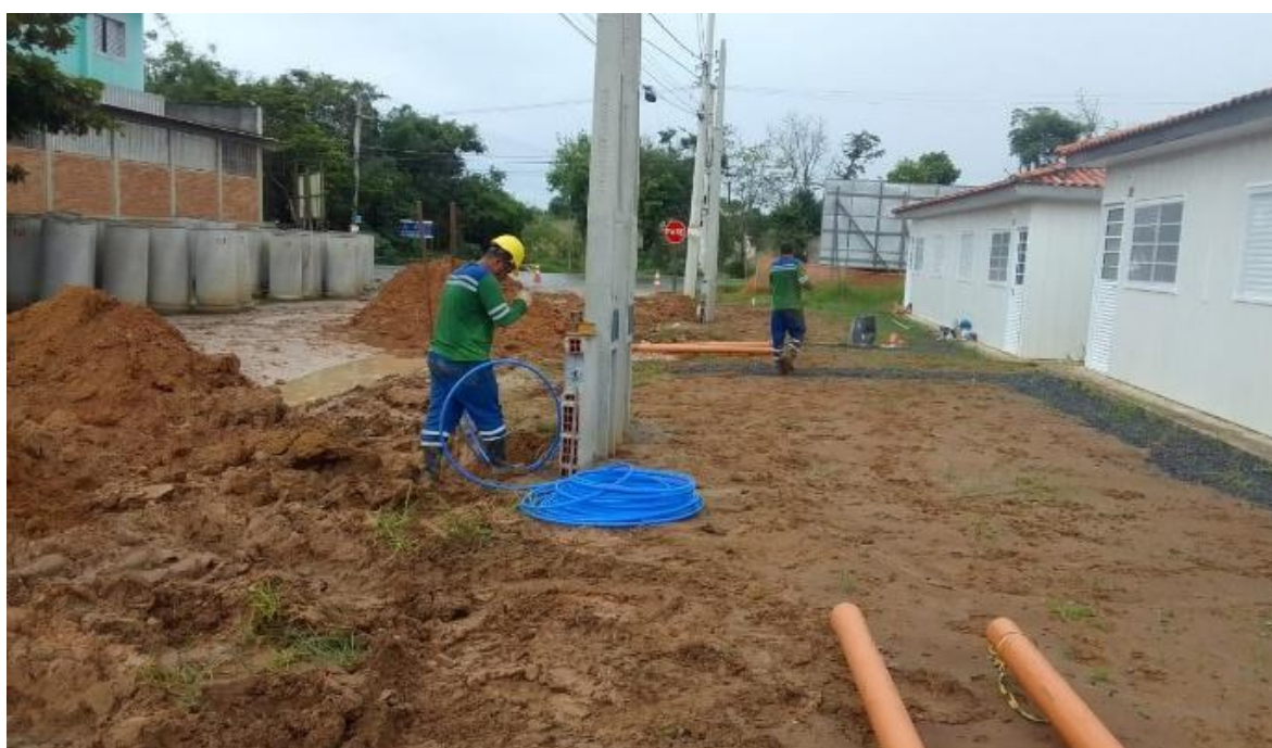
EXECUÇÃO DAS LIGAÇÕES DE ÁGUA E ESGOTO
